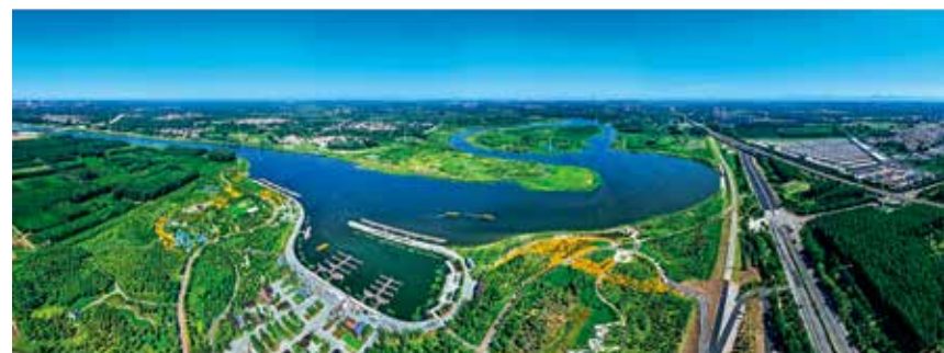
河北省廊坊市香河县运河中心码头
